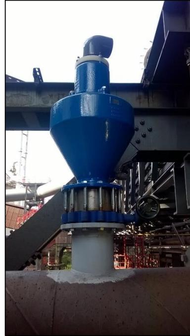
Kombiniertes Be- und Entlüftungsventil am Hochpunkt installiert
