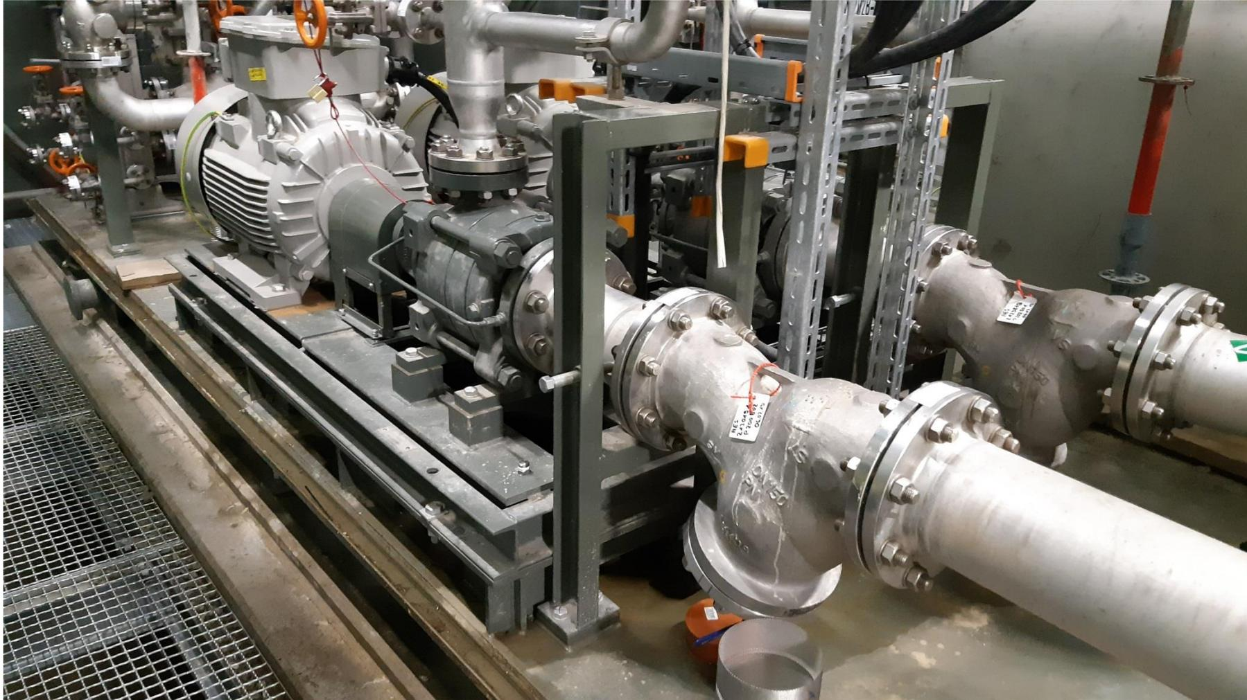
Bei der Inbetriebnahme eines Anlagenteiles kam es zu Kavitation an den Sperrwasserpumpen, ausgelöst durch Strömungsablösung nach dem saugseitigen Filter
