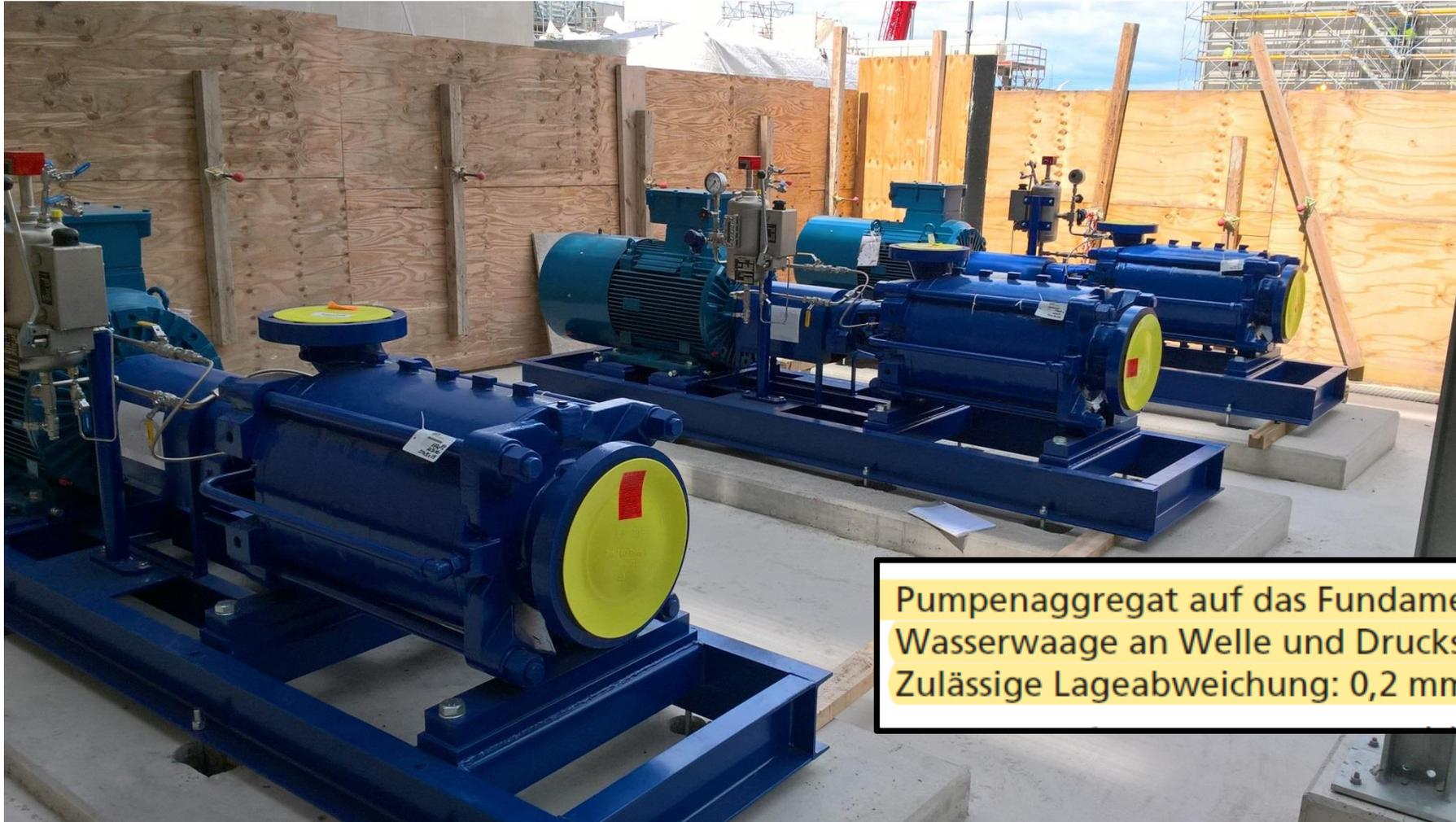
Pumpenaggregat auf das Fundament aufstellen und mithilfe einer Wasserwaage an Welle und Druckstutzen ausrichten.
