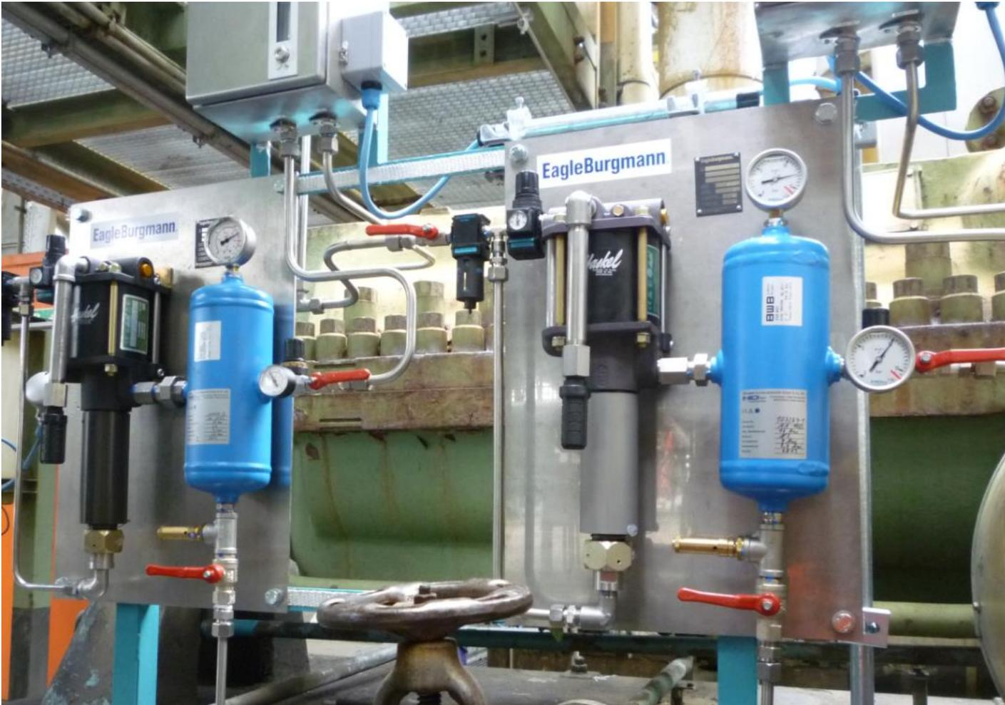
$N_2$  – Druckerhöhungsanlage auf ca. 10 barg
