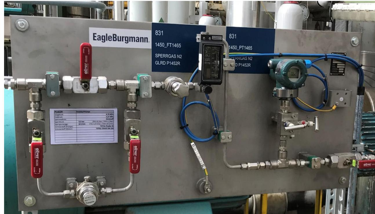
Sperrgas-Versorgung der atmosphärenseitigen zusätzlichen Gasdichtung API Plan 72 mit Alarmierung durch Transmitter
