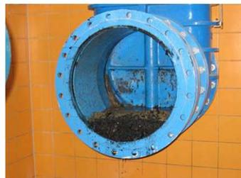
Bild 30: Saugleitung, geringe Strömungsgeschwindigkeit
