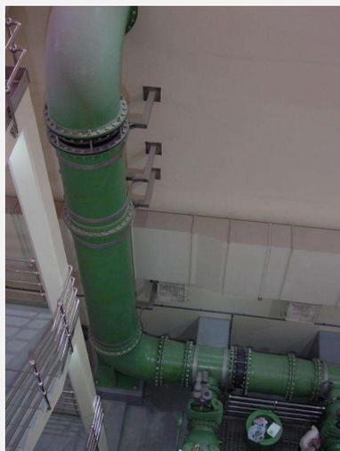
Bild 35: Ungeeignetes Design einer Sammeldruckleitung für Einzel- und Parallelbetrieb
