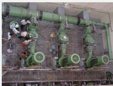
Bild 36: Einbindung der Pumpen in Sammelleitung
