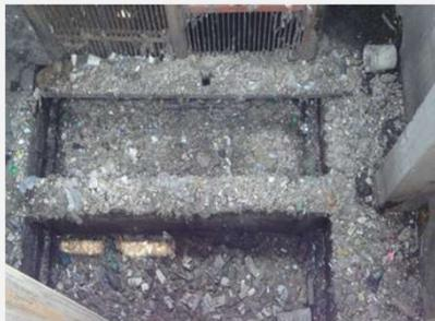
Bild 5: Müllentsorgung; Mangelhafte Rechenanlage
