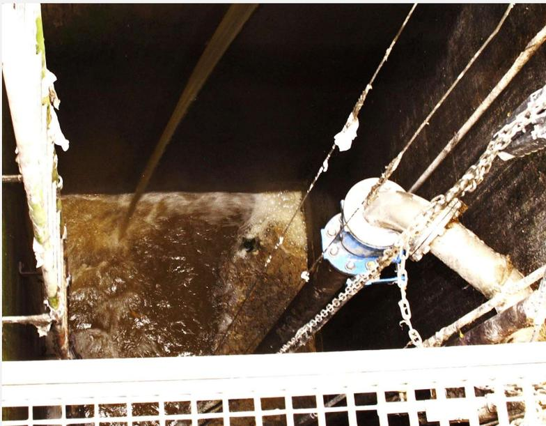
Bild 38: Freier Absturz, Lufteintrag sowie Bildung einer Schwimmdecke
