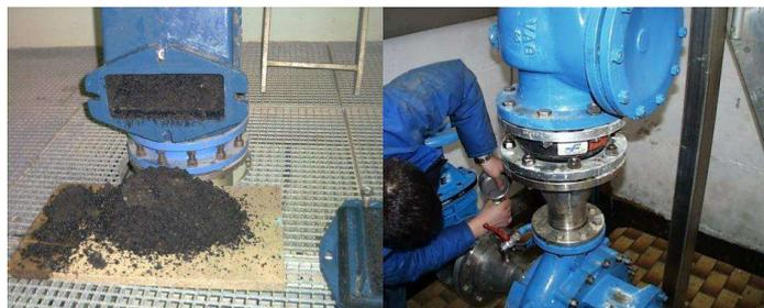
Bild 29: Feststoffablagerung in Steigleitung (DN200); DN80 Druckstutzen
